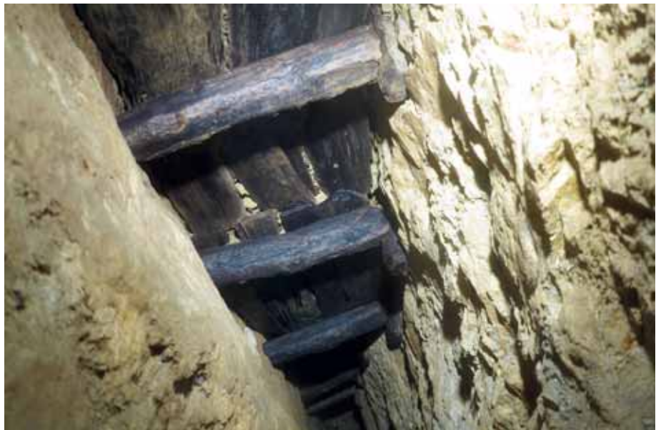
31 Zimmerung mit Versatzpackung in der Zwischensohle (Bild Luisa Karrer)
