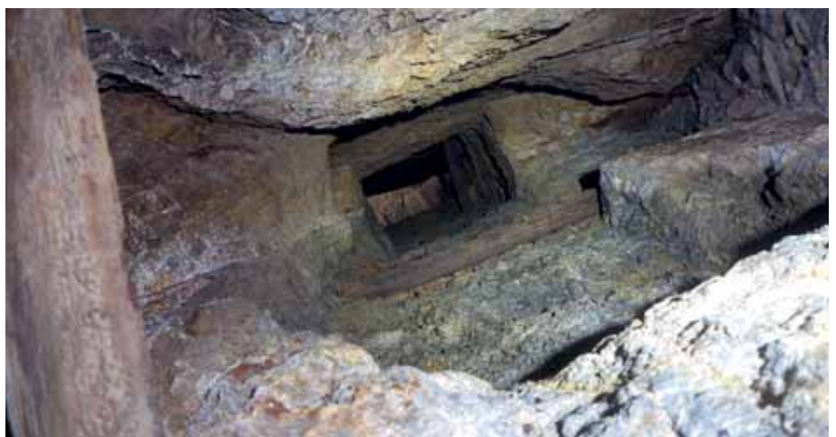
33 Förderschacht mit Seilführungsholz auf halber Höhe in der Zwischensohle; Ansicht von unten nach oben (Bild Luisa Karrer)
