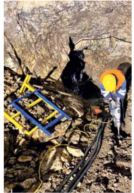
14 Einbau der elektrischen Leitung
