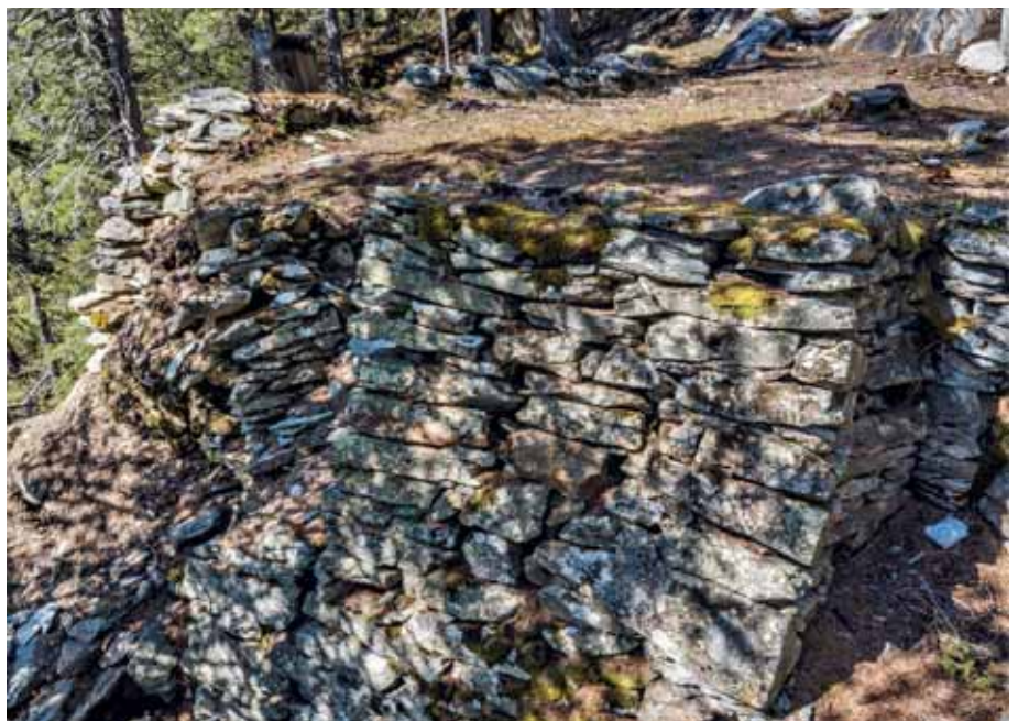
Fotoprotokoll zum Zustand der Seilbahnplattform und der Rollbahn
