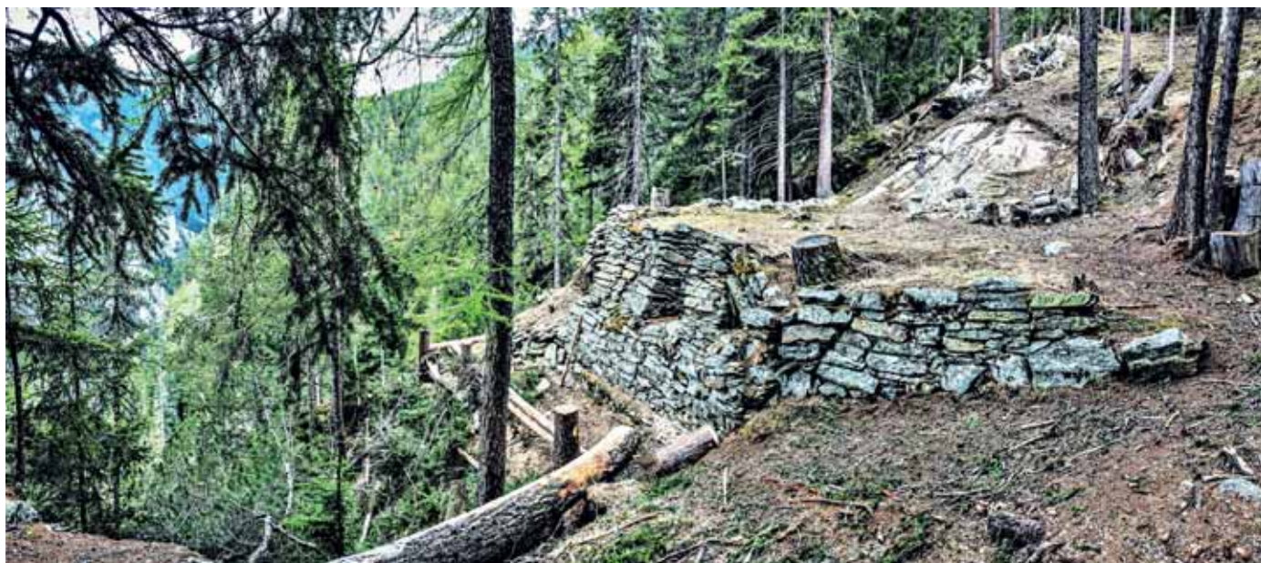
Zustand des Mauerwerks der alten Seilbahnplattform
