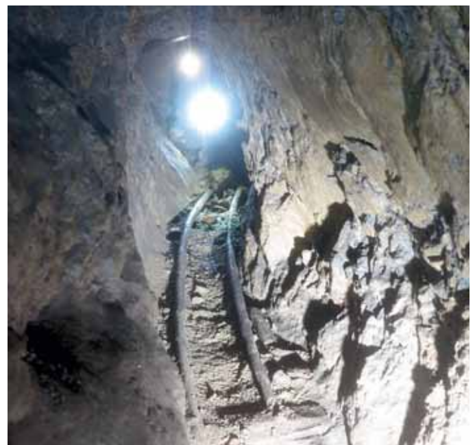
20 Abbaustrecke Erzgang 2 mit verlegten Rundschienen (Bild Luisa Karrer)
