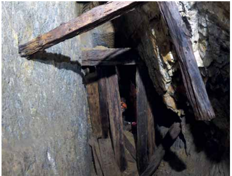
25 Strecke Sonch Rafael II: Demontiertes und als Absperrung verwendetes Haspelgestänge (Bild Luisa Karrer)
