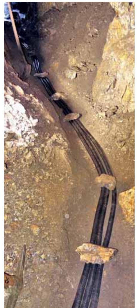
15 Die elektrische Leitung ist verlegt
