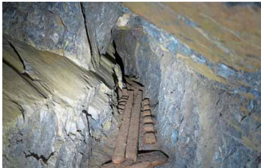
12 Hölzernes Gestänge für die Spurnagelhunte mit seitlich platzierten Steigbäumen zur Überwindung leichter Höhendifferenzen im Stollen Zarcla (Bild Luisa Karrer)
