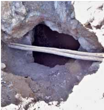
08 Das geöffnete Lichtloch vor dem neuen Holzverbau
